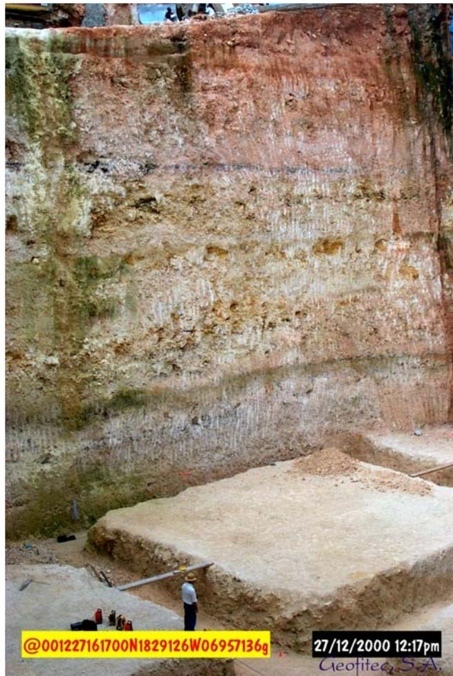
EXCAVACION DE 24 METROS DE PROFUNDIDAD PARA LA CONSTRUCCION DE UNA TORRE EN STO. DGO.
